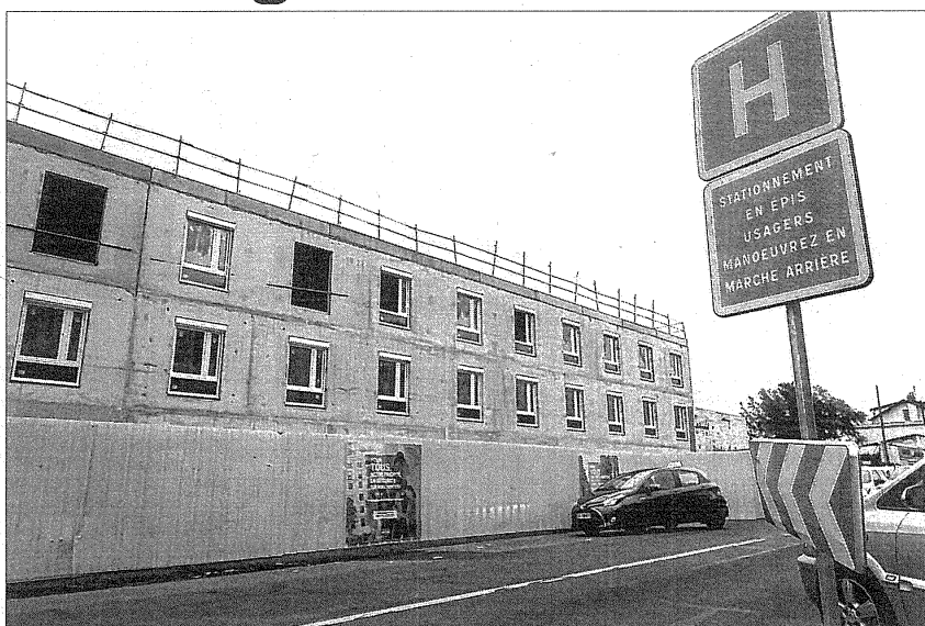
■ Avenue du Doyen Jean-Lépine, dans le secteur des hôpitaux, un Ehpad, Les Agapanthes (122 lits), est en cours de construction. Cette opération privée s'inscrit dans le cadre du transfert d'un établissement basé actuellement à Vaulx-en-Velin. Photo H. P.
